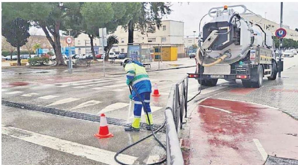
El Ayuntamiento, a través de Aquajerez, ha reforzado la limpieza de las redes de saneamiento en los puntos de la ciudad más sensibles a inundaciones.
