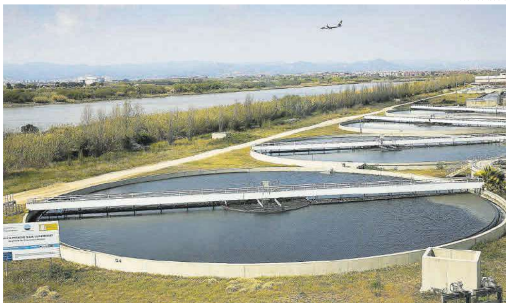
La depuradora de El Prat de Llobregat es una de las plantas de saneamiento de aguas residuales más grandes y modernas de Europa.
