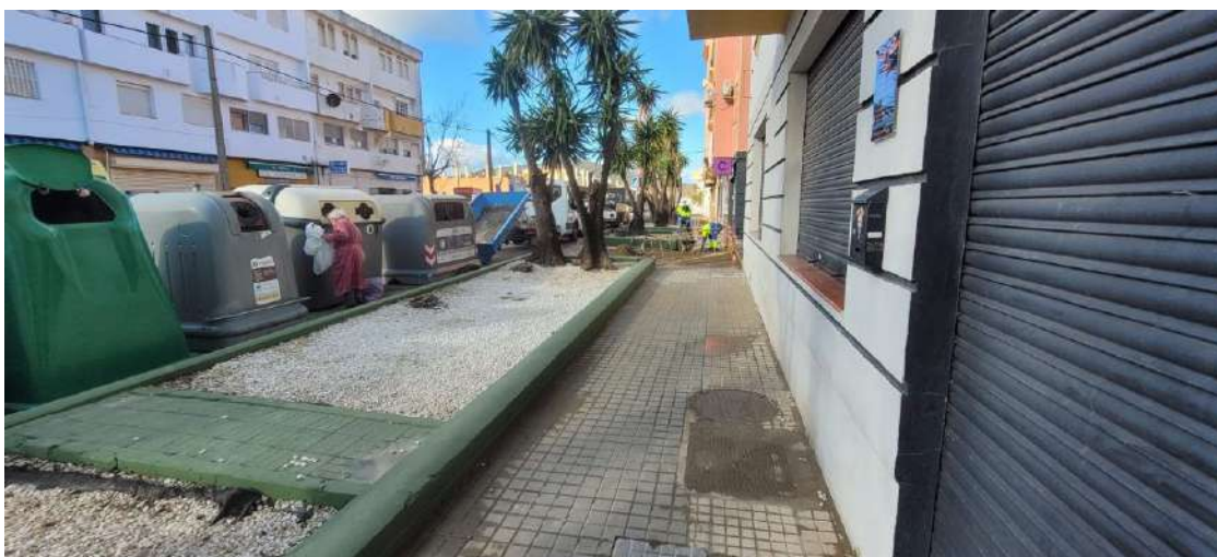
aqualia obras avenida maria guerrero la linea - Aqualia renovará un tramo de tubería en la avenida María Guerrero de La Línea tras ocho días sin suministro de agua
